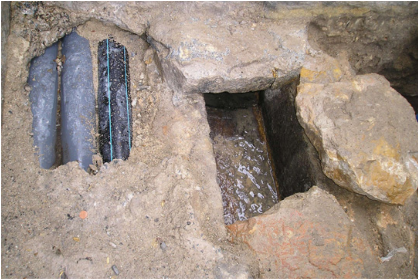
El canal del Acueducto a su paso por Daoiz (detalle)
