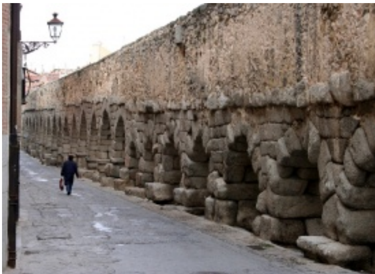
Acueducto en su inicio
