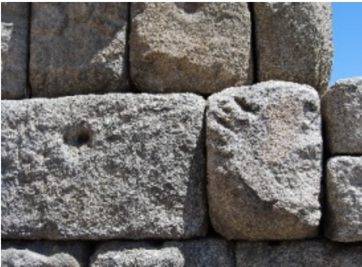
Detalle de sillares
