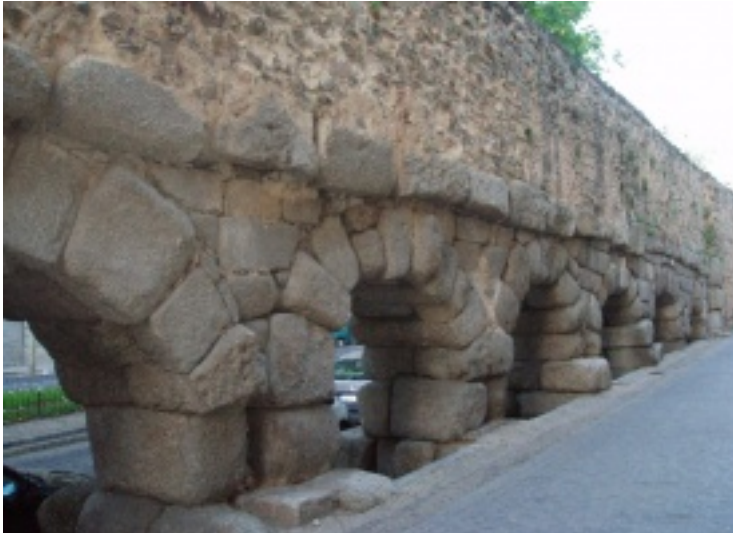
Acueducto en su inicio
