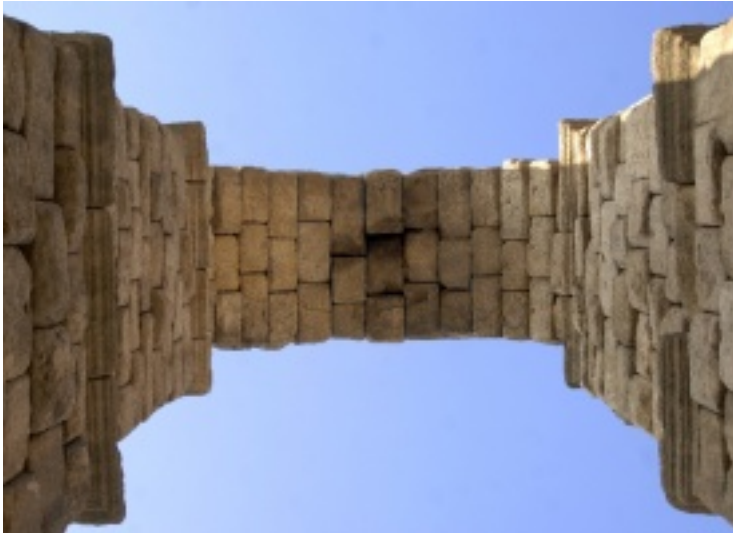
Detalle arco desde abajo
