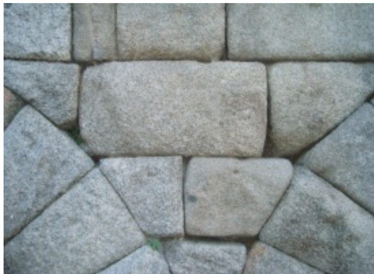
Detalle de los sillares del Acueducto
