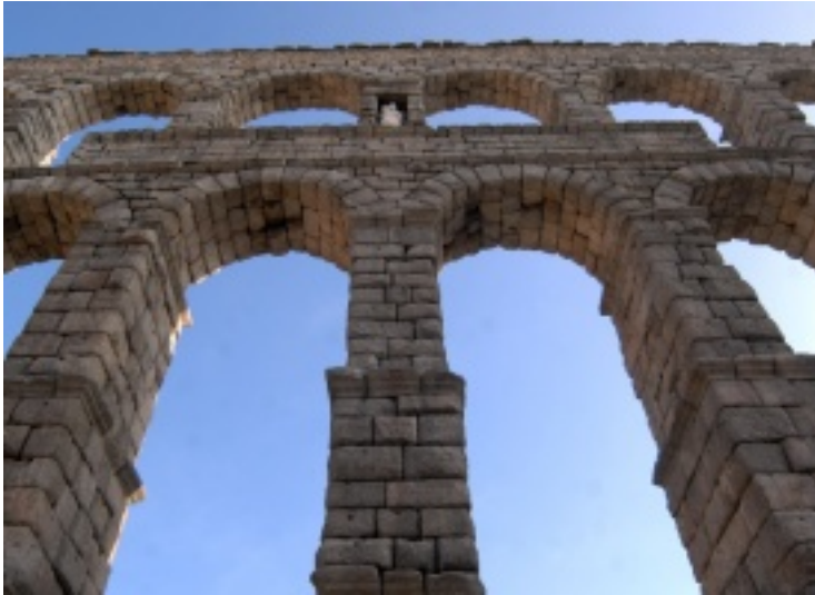
Arcos del Acueducto
