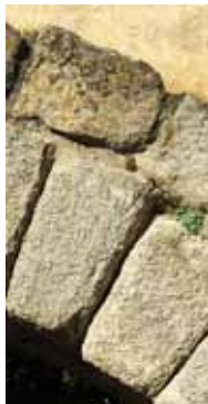
Detalle del último arco del Acueducto en la plaza de Avendaño.
